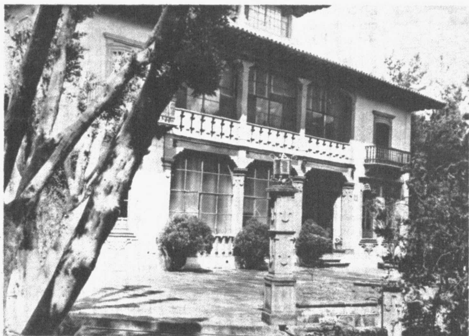
Edificio principal del Centro
