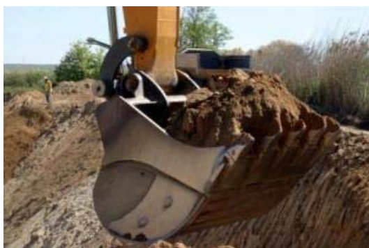
Extracción de los materiales mediante perforación
