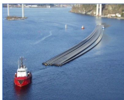
Transporte de tuberías del emisario
