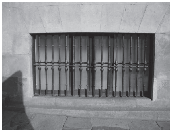
Fig. 4. Las rejas como frontera entre lo público y lo privado
