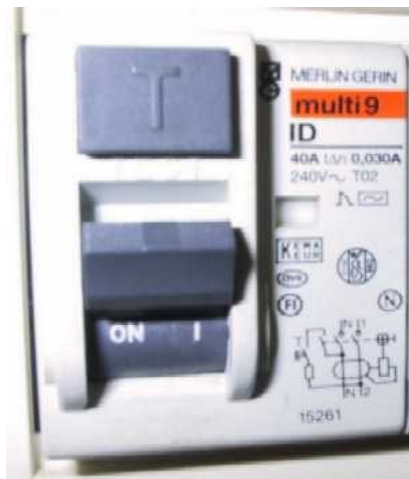
Detall d'un interruptor diferencial
