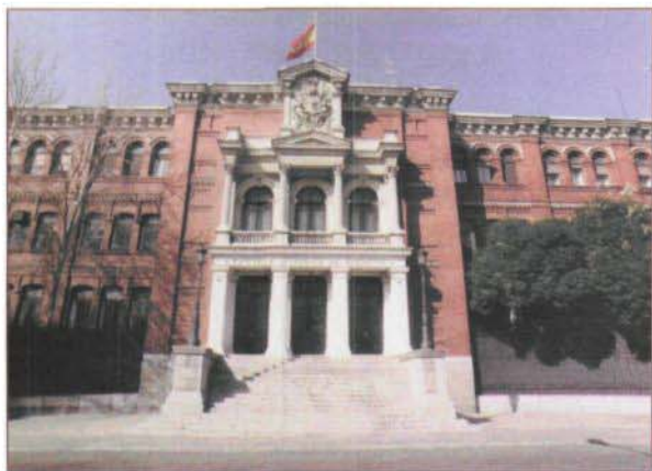
Figura 3. Fachada actual del edificio que albergó el Colegio Nacional de Sordomudos y de Ciegos en el Paseo de la Castellana, Madrid.
