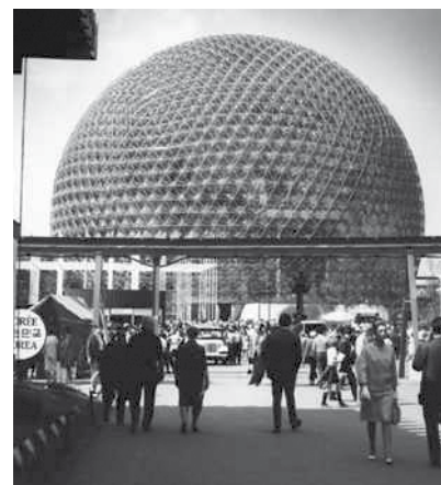
Cúpula geodèsica (Montreal, 1967).
