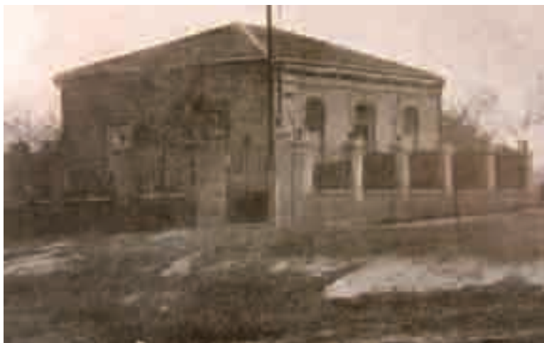
Casa en La Guindalera
