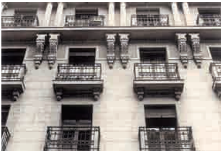
Fachada de la casa del número 16 de la calle Conde de Aranda, en la que Zenobia Camprubí y Juan Ramón vivieron desde julio de 1916 hasta agosto de 1921
