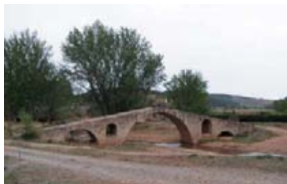
Puente Romano de Luco de Jiloca
