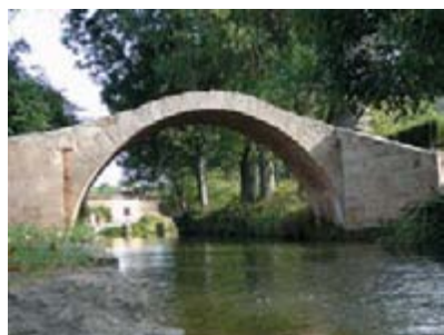
Puente romano de Calamocha
