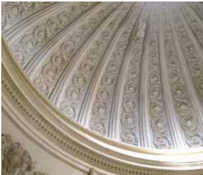
Bóveda del palacio de “Vista Alegre”.
