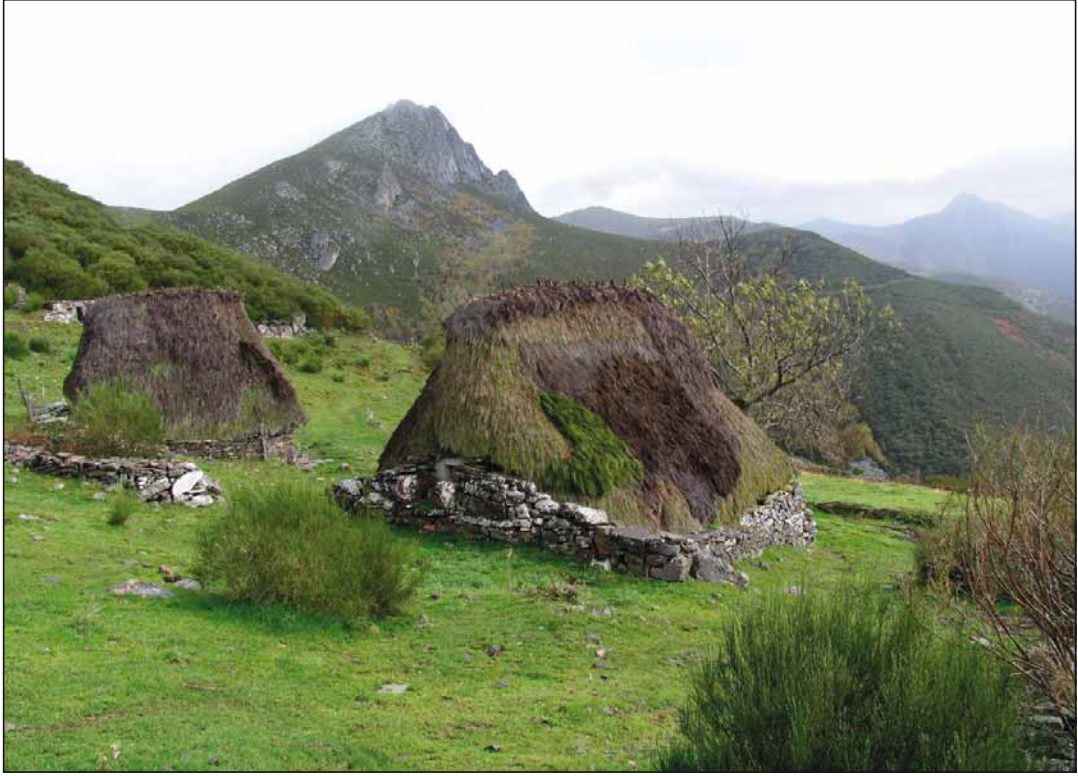
Figura 59. Teitos de Mumián, en los que se aprecian diferentes estadios de la renovación de la cubierta, los más recientes con la escoba aún verde.
