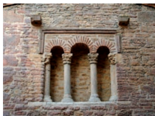
Detalle de la ventana
