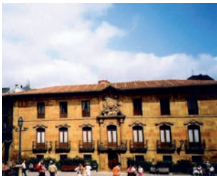
Fachada meridional del Palacio de Valdecarzana-Heredia
