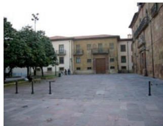
Vista del Palacio Episcopal desde la Corrada del Obispo. A la derecha la fachada del claustro de la catedral. Entre ambas el tránsito de Santa Bárbara.
