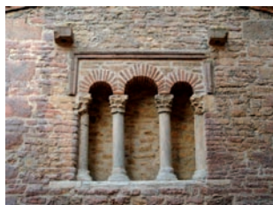
Detalle de la ventana
