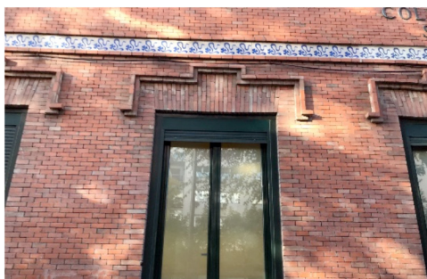
Figura 13. Detalle de la fachada. Imagen actual.
