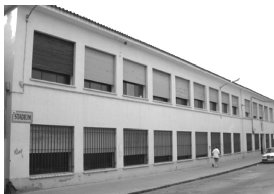
Fachada colegio en Pardaleras.
