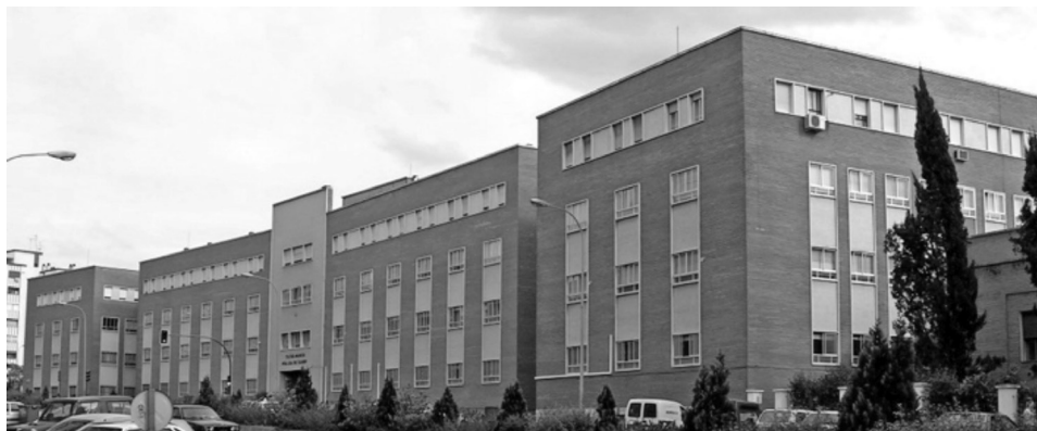
Fachada del Colegio de los Maristas.
