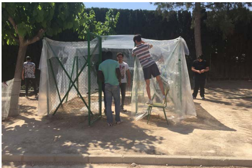
Ilustración 4. Construcción del invernadero. Fuente: elaboración propia
