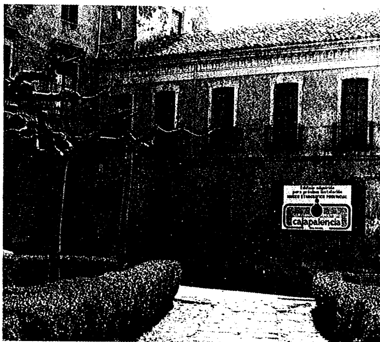
Fotografía núm. 1.- SITUACION ACTUAL DE LOS ANTIQUOS LOCALES DE LA ESCUELA NORMAL DURANTE EL PERIODO COMENTADO EN ESTE ARTICULO.
