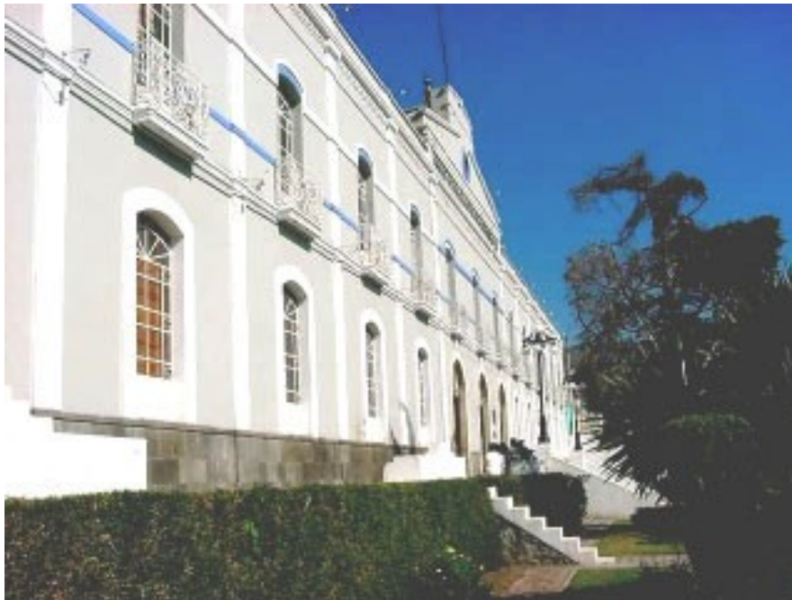
Figura 2: Edificio Central de la actual Universidad Autónoma del estado de Hidalgo
