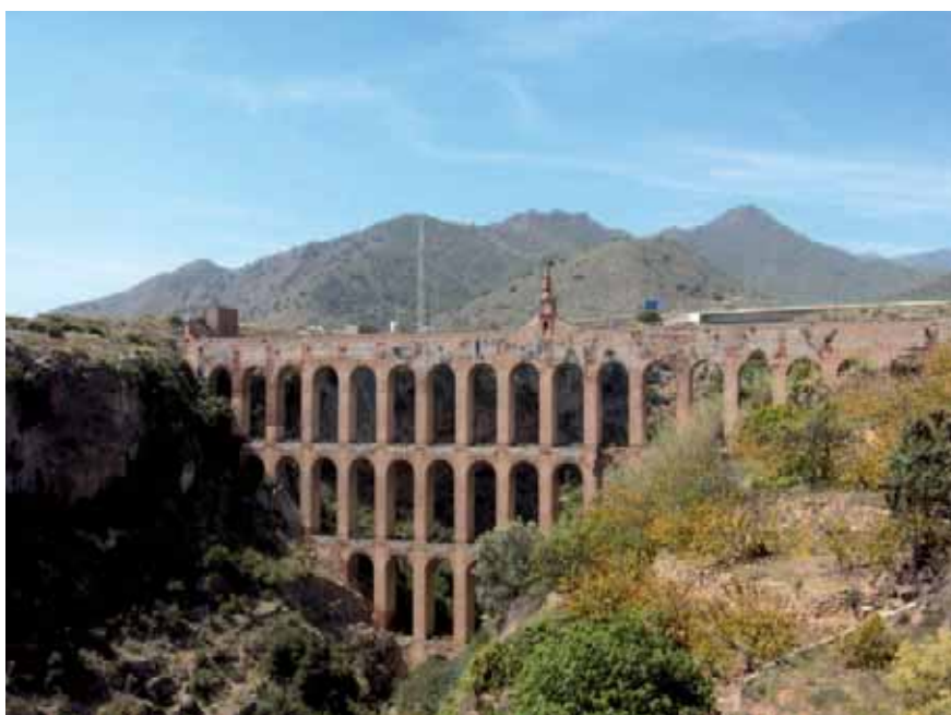
Acueducto del Águila. Fuente: Sopde.
