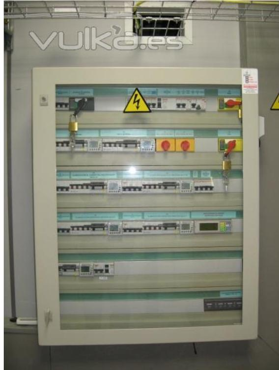
Fig.9. Modelo de cuadro eléctrico para control de instalaciones
