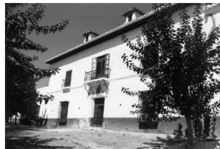
Casa Gnecco en rambla del Zarzal. Adra.
