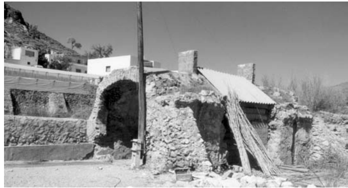
Vista exterior de los baños de Benejú.
