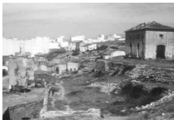
Restos de la fundición de San Andrés (Adra)
