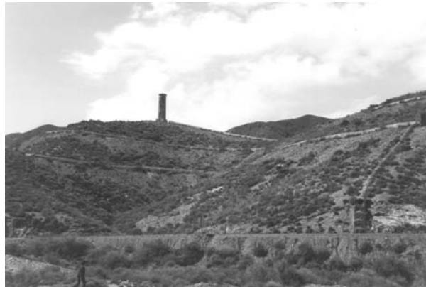
Galerías serpenteantes por la montaña hasta concluir en la chimenea superior.
