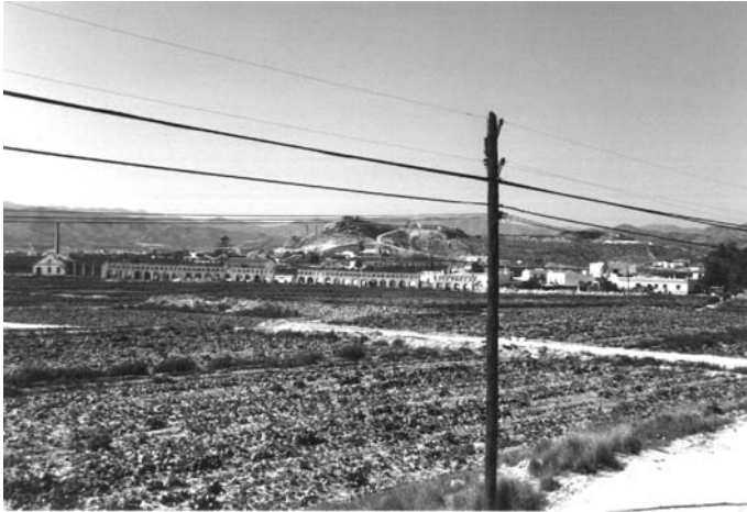
Vista general del acueducto.
