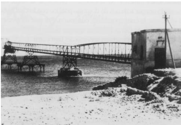
Embarcadero metálico de Villaricos.
