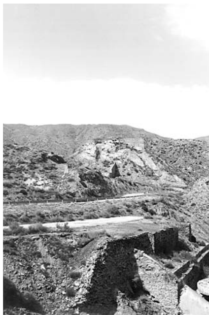
Restos del cable minero, apreciándose en el centro el gran depósito-tolva.
