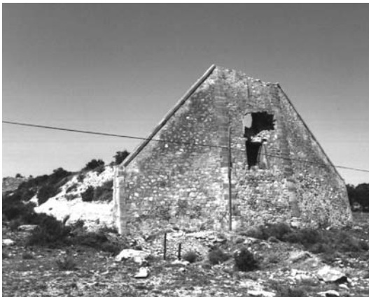
Restos del terraplén de acceso al embarcadero metálico.
