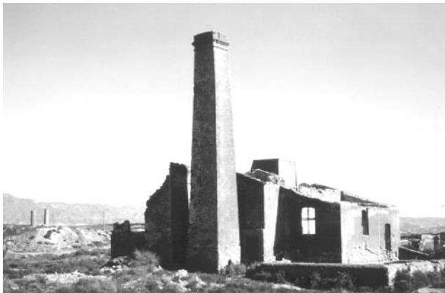
Instalaciones de la mina Sta. Ana - Herrerías. (Demolición en Nov. 1993).
