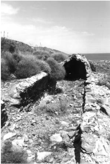
Ruinas de las galerías de condensación.
