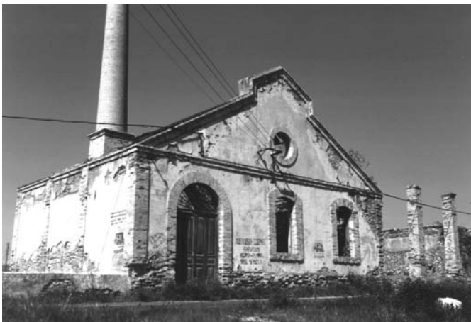
Caseta de la máquina de vapor para elevar el agua.
