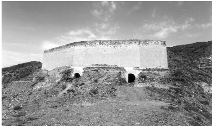
Depósito-tolva de acceso al embarcadero metálico.
