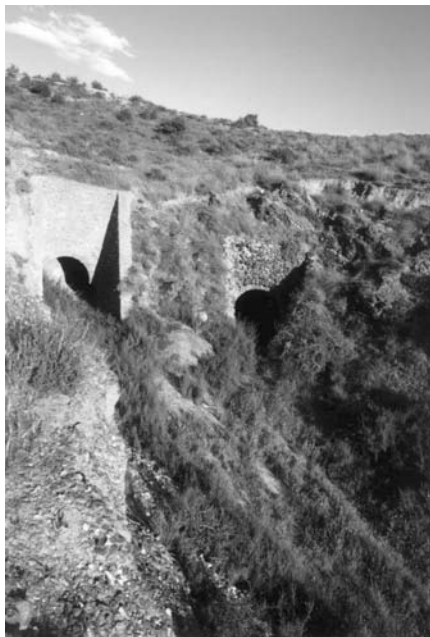
Túneles del ferrocarril minero Herrerías-Villaricos.
