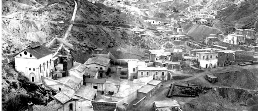
Barranco del Jaroso. Vista del desagüe.
