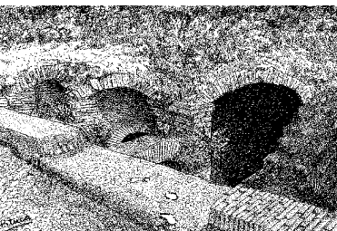
Aljibes de primer Recinto
