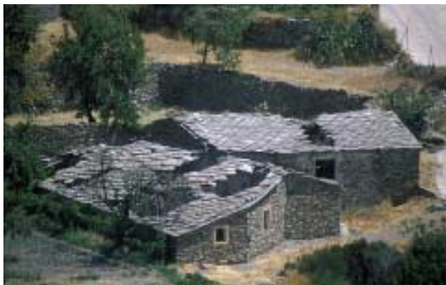
Destrucción paulatina de la arquitectura popular
