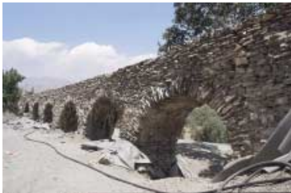
Acueducto para el molino de Las Juntas
