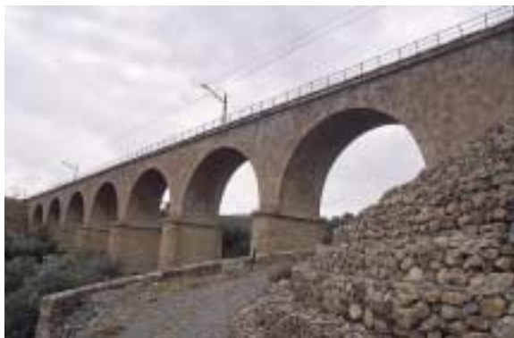
Puente de ferrocarril de la Rambla de las Adelfas.
