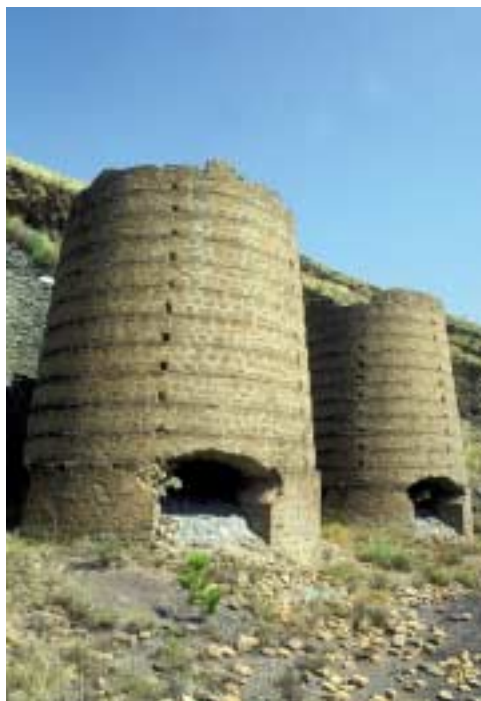
Hornos de calcinación en Arroyo Verdelecho
