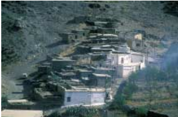
Techos de launa y muros de pizarra en Los Milanes (Abla)
