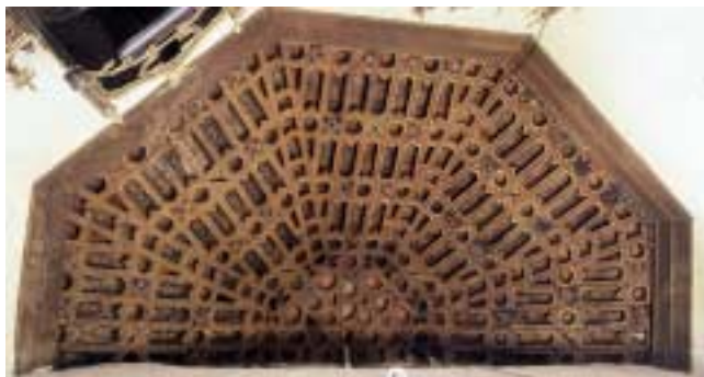
Armadura ochavada de la capilla mayor de la iglesia de Abla
