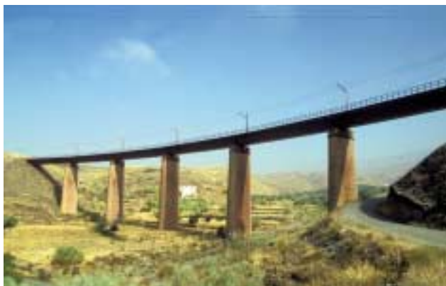
Puente de ferrocarril sobre la rambla de Escúllar.
