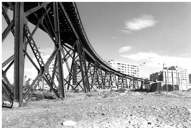
Viaducto metálico del cable Inglés.
