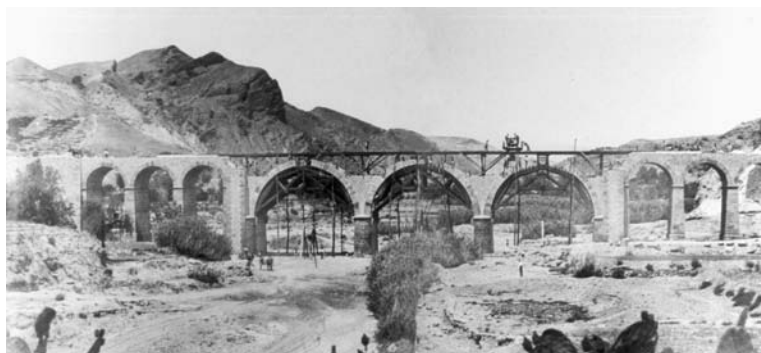
Construcción del puente sobre la rambla de Parias. Huércal Overa.
