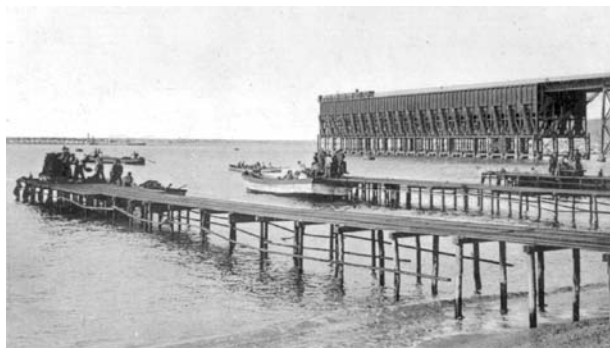
Vista del cable Inglés recién construido.
