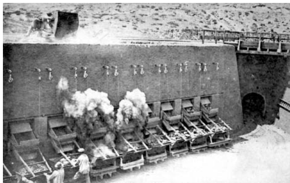
Sociedad Minera de Almagrera. Carga de mineral a la salida de los hornos.
