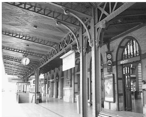
Vista parcial de los andenes.
