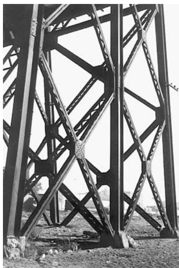
Pilares metálicos del viaducto.
