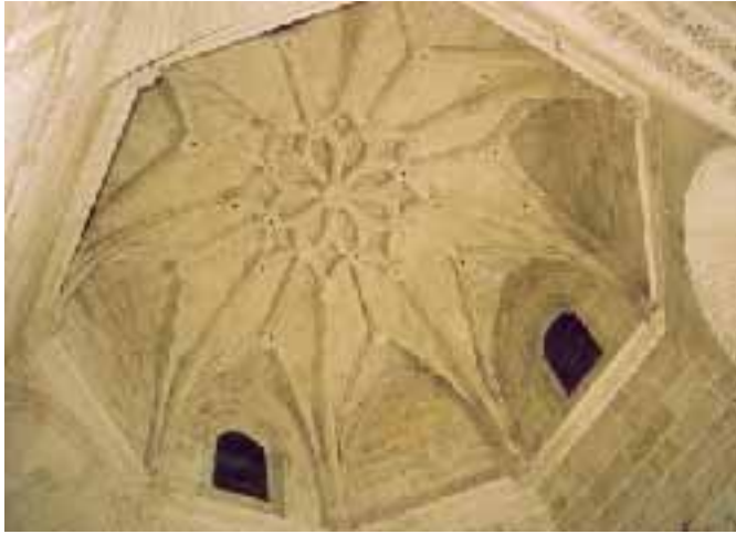
Bóveda del crucero.
