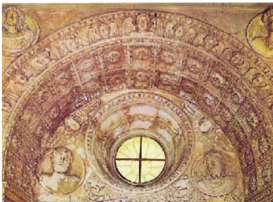
Detalle de una arcada de la sacristía.
