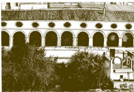
Casa de los Baños.
