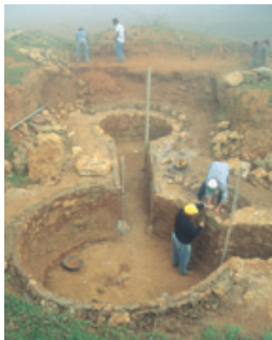
Figura 40: Detalle de la reconstrucción de las cámaras de la Tumba del Término.
