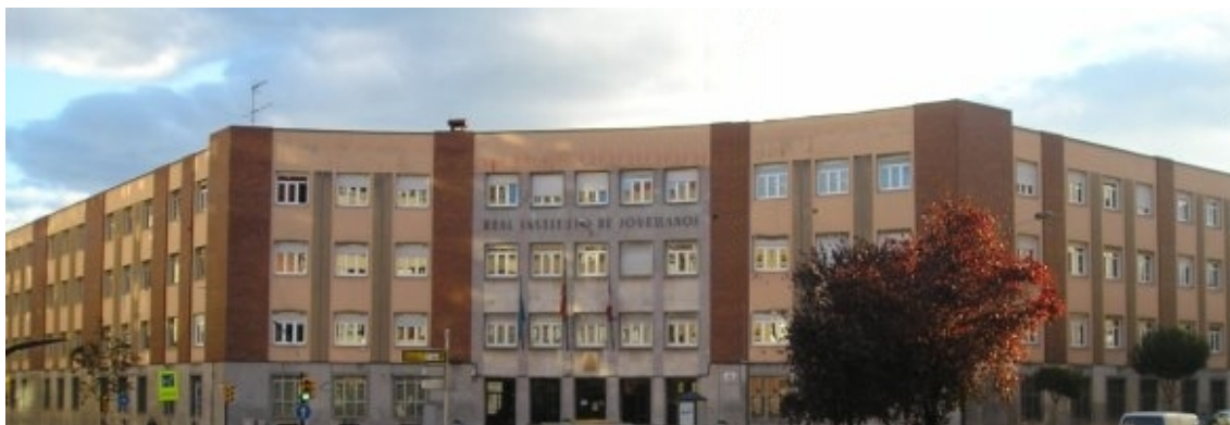
Imagen 1. Fachada principal del Real Instituto de Jovellanos de Gijón
