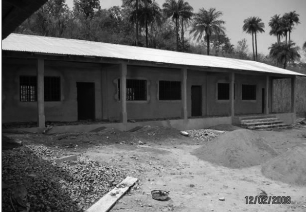
Foto 3: Escuela de Kamayusufu promovida por José Luís quien da los materiales y enseña a construirla a la comunidad que participa en su construcción.
