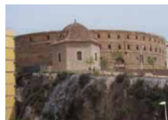
La pervivencia de lo clásico: la plaza de toros de Cartagena está construida sobre el antiguo anfiteatro romano
