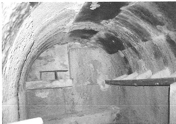
Foto 4. Bóveda de cañón formada por cinco dovelas que cerraba el sepulcro en su parte superior. En el arranque de la misma es donde hemos tomado las dimensiones del recinto interior
